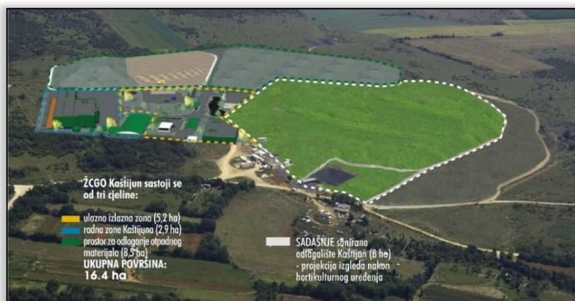
Slika 14. Zona za odlaganje otpada CGO Kaštijun
